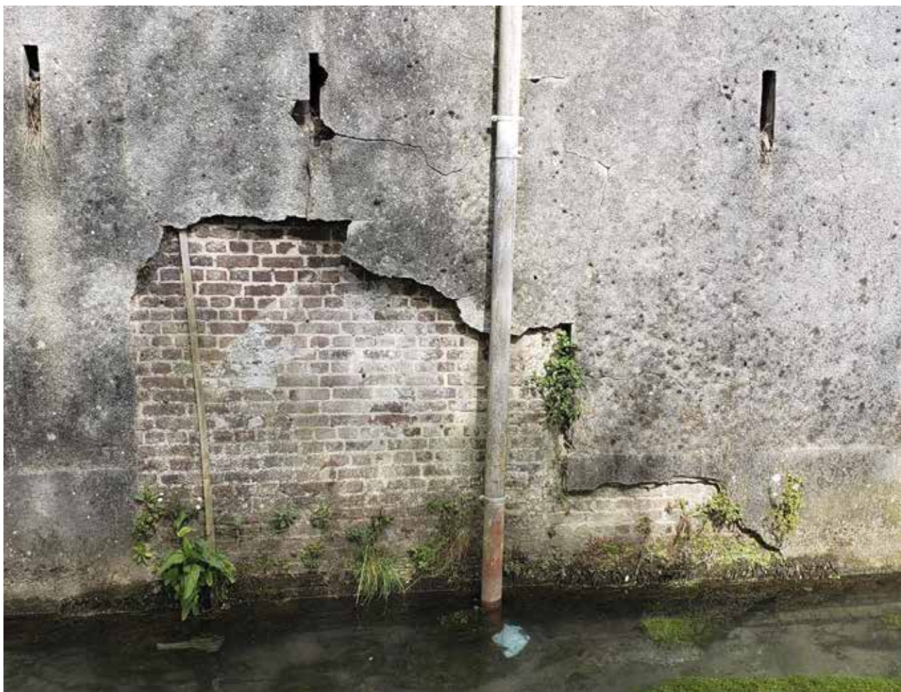
FIGURE 6 : Décollement de l'enduit le long du Robec vraisemblablement provoqué par les remontées capillaires. – Source : image des auteurs, 2022.
