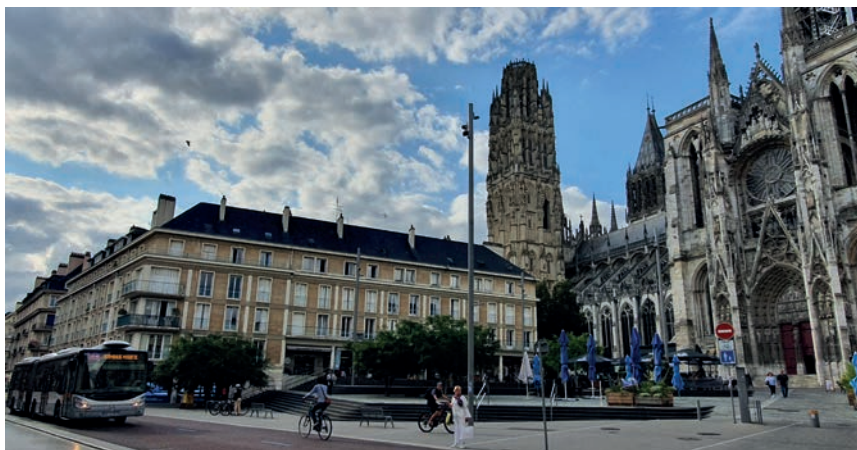
Circulation partagée entre les cyclistes et les TEOR sur les voies réservées à ces derniers à Rouen (© Cerema)
