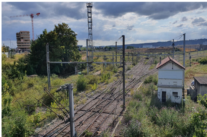
Faisceau ferroviaire de desserte du port maritime (© Cerema)
